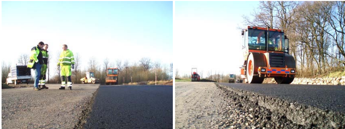
Bild 6-2 Vältförarna tvingas vänta tills RA-massan svalnat innan maskinerna kan gå på utan att ytan spricker. Notera den vertikala kanten, som uppstår med en stum och oflexibel massa. Källa: /3./
