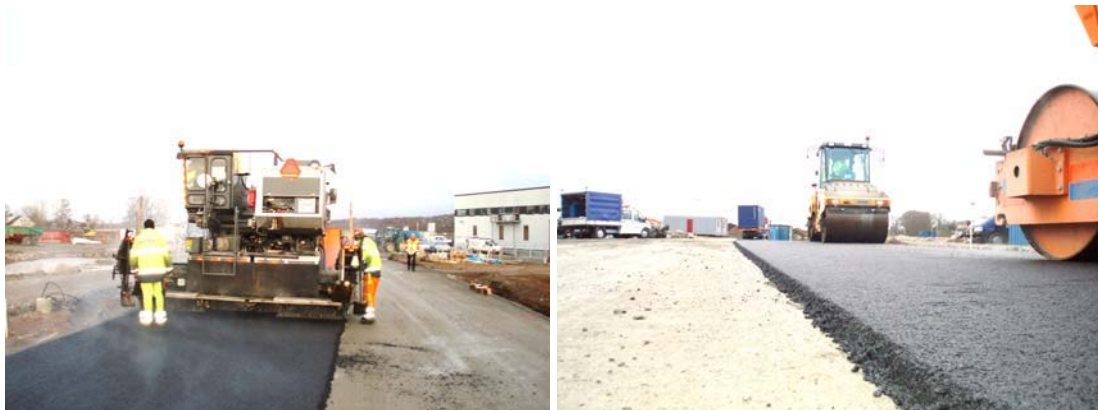
Bild 6-3 Vältarna kunde börja bearbeta FRA-massan direkt efter utläggaren. Kanten på läggardraget bildar en rasvinkel som resultat av massans levande karaktär. Källa: /3./
