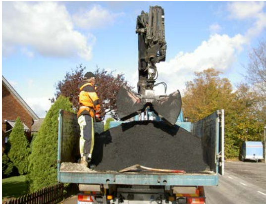
Bild 3-6 Öppet flak och gripskopa jämfört med förslutet, isolerat flak med Sprider.
