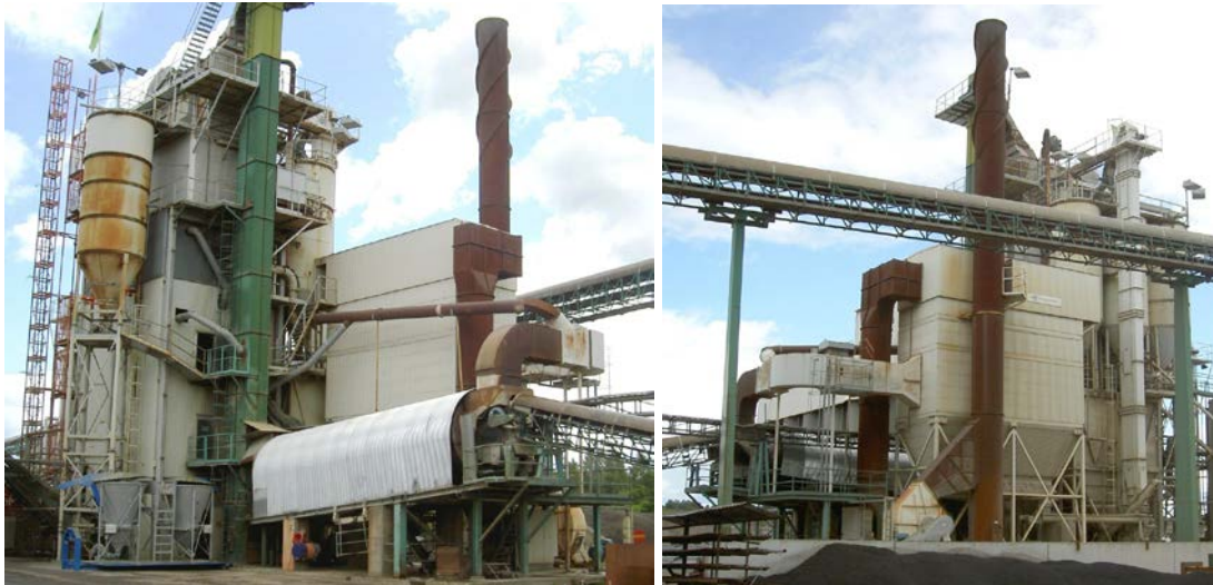
Bild 4-2 Ventilationskanaler går från flera utsug med damm och rökgaser till filteranläggningen för rening.
