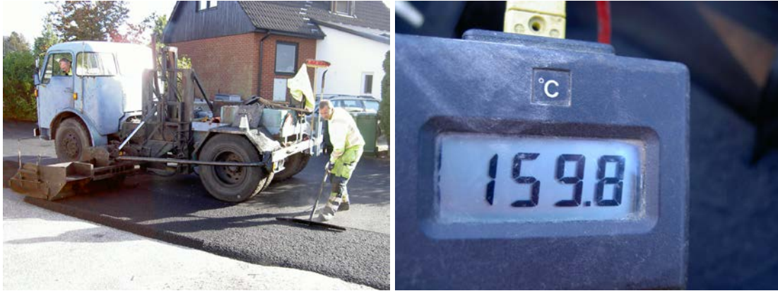
Bild 6-6 Den gamla trottoarläggaren på bilden är fortfarande ett uppskattat hjälpmedel. OTA-massan var lättlagd vid normala temperaturer.
