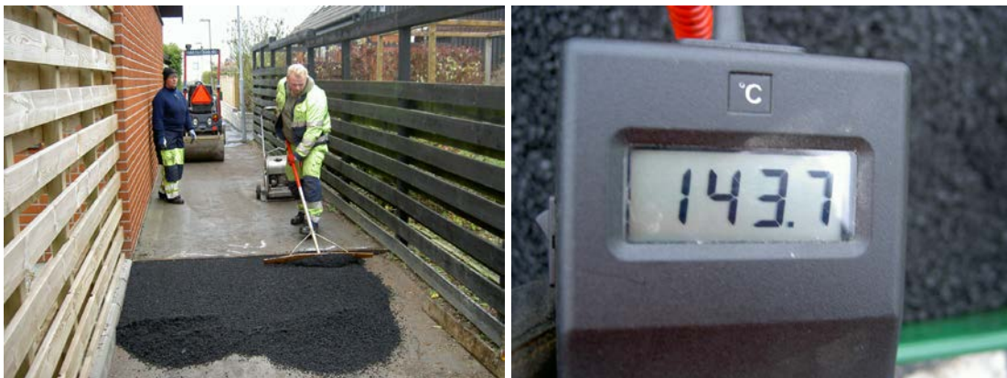
Bild 6-8 I trånga utrymmen måste asfaltmassans ibland bäras fram för hand. Då krävs att den fortfarande kan läggas ut och komprimeras när temperaturen sjunker.
