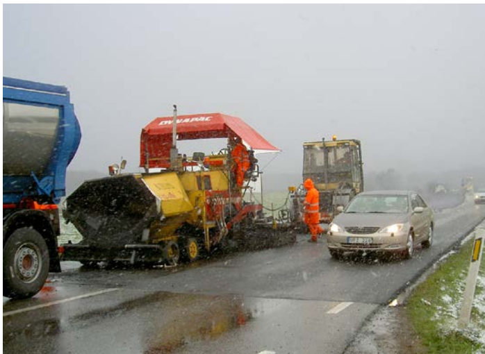
Bild 3-4 Asfaltläggning i snöglopp på den skånska slätten. För husfridens skull får massan extra värme.
