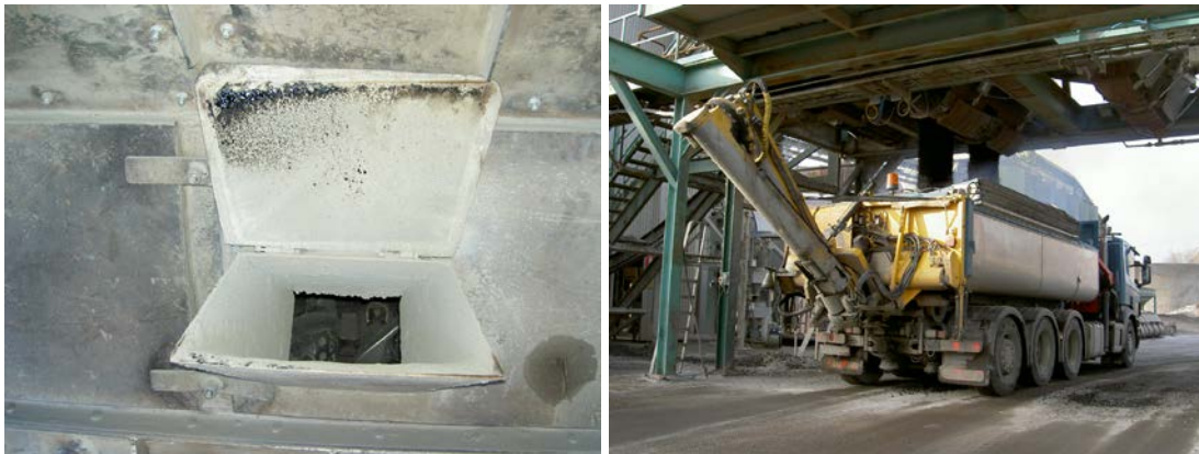
Bild 6-5 Doseringsluckan för Sasobit in i asfaltblandaren. ”Spridern” fylls med handläggningsmassa för hela eller halva dagsbehovet.
