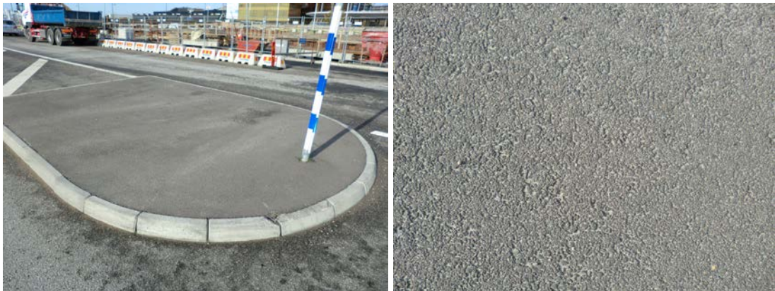
Bild 6-10 Tre år efter utläggning och utan efterpackning av trafik ser refugytan med OTA-massa fortfarande tät ut.
