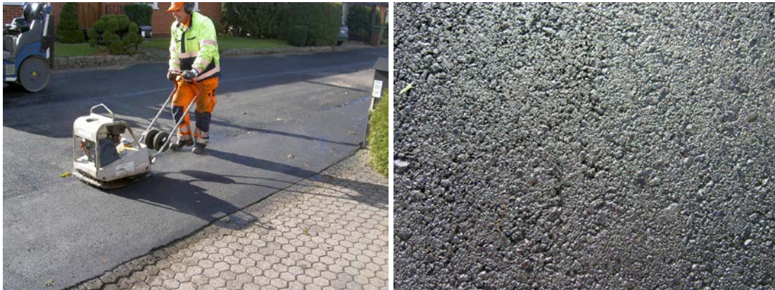
Bild 6-7 Den smidiga och formbara massan gav täta och starka övergångar till anslutande ytor. Närbilden visar att massan har en balanserad sammansättning av stenstorlekar och bruk.
