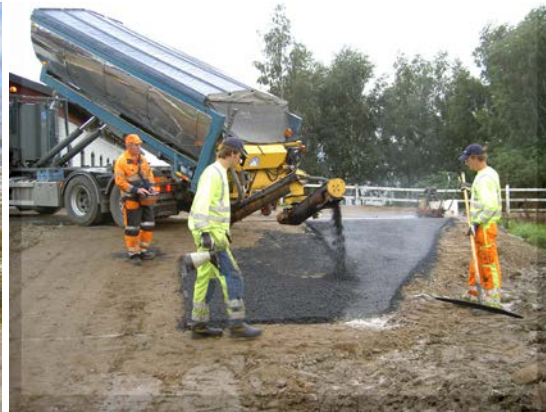
Bild 3-6 Öppet flak och gripskopa jämfört med förslutet, isolerat flak med Sprider.
