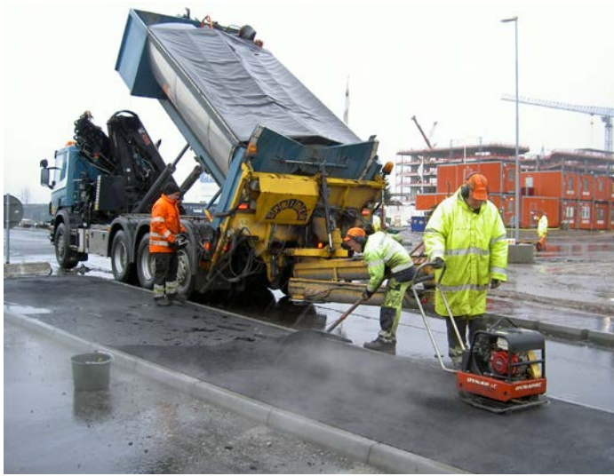
Bild 3-3 Handläggning klaras även under ogynnsamt väder med uppvärmt, förslutet flak och Sprider. Extra värme behövs egentligen inte men får det i alla fall av gammal vana.
